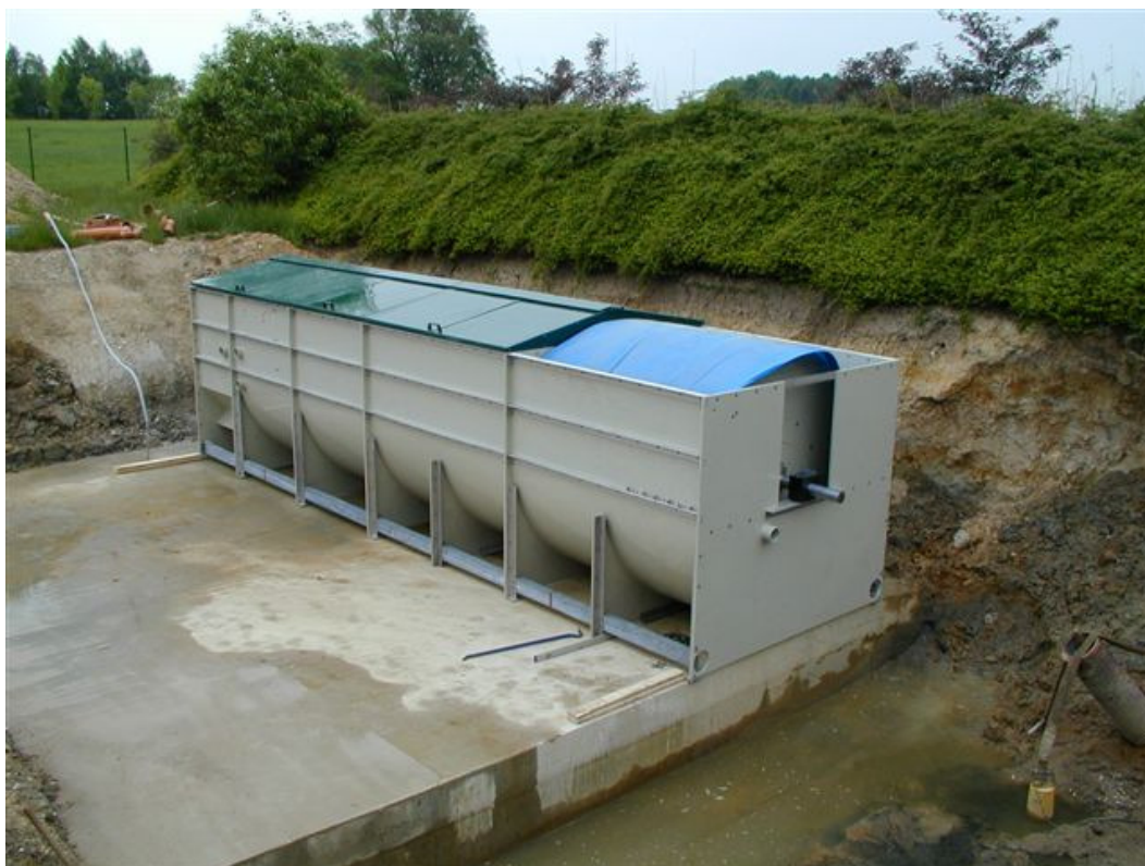
Foto 4. Reoveepuhasti paigaldamine
